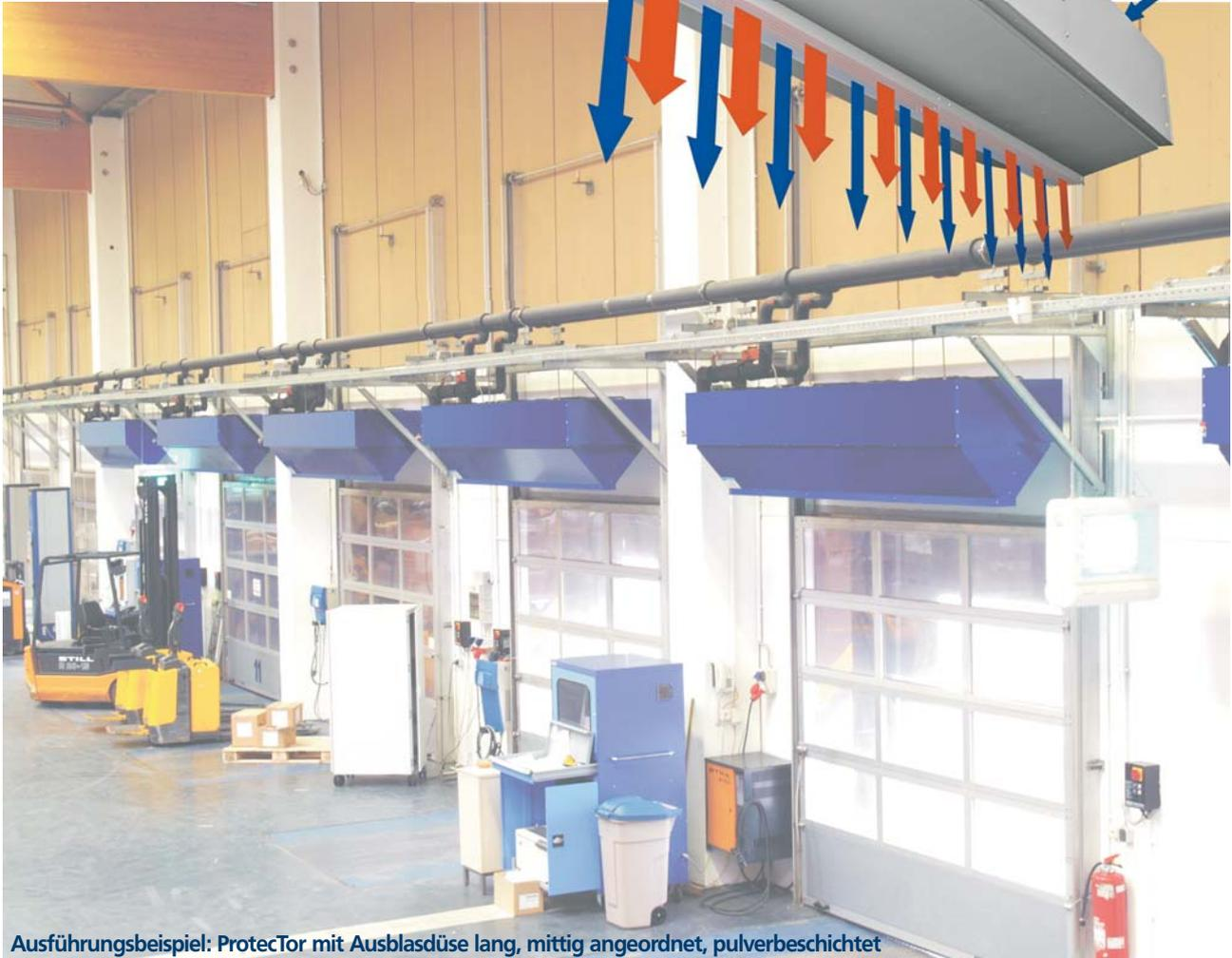
Ausführungsbeispiel: ProtecTor mit Ausblasdüse lang, mittig angeordnet, pulverbeschichtet
