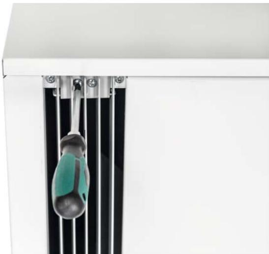
Zum Einstellen der Luftausblasrichtung ziehen Sie die Schrauben des Luftaustrittsgerichters an, bzw. lösen Sie diese, je nach gewünschter Ausblasrichtung.
